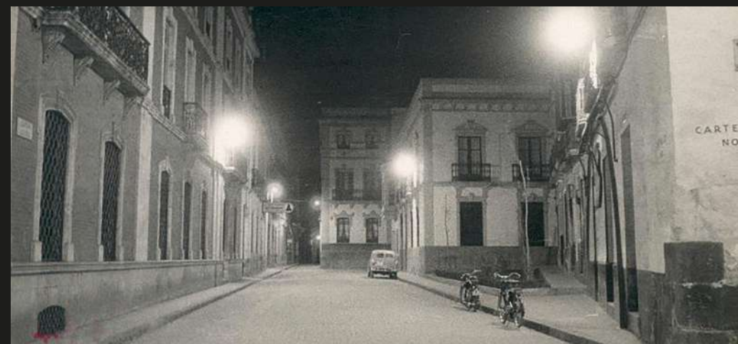
Obras del parterre y nuevo alumbrado en la calle García Lovera, c. 1950 [Ladis/Archivo Municipal de Córdoba].
