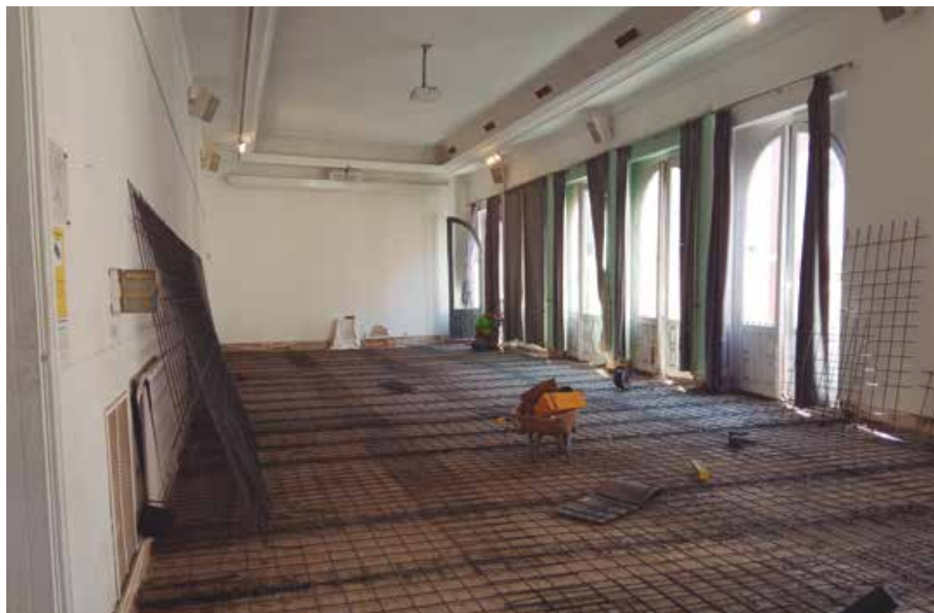
Fotografía durante los trabajos de rehabilitación de la sala.
