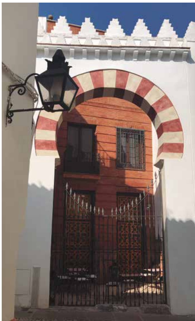
Fachada lateral del hotel.
