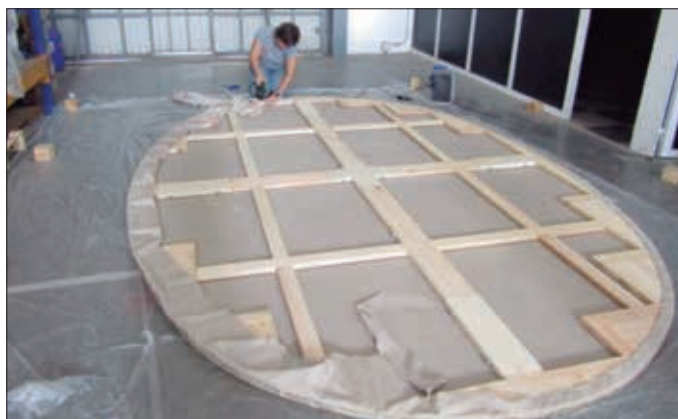
Instalación del nuevo bastidor.
