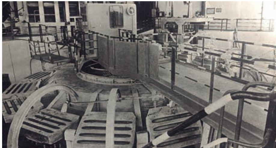
Horno de fusión de cátodos y ruleta de colada.
