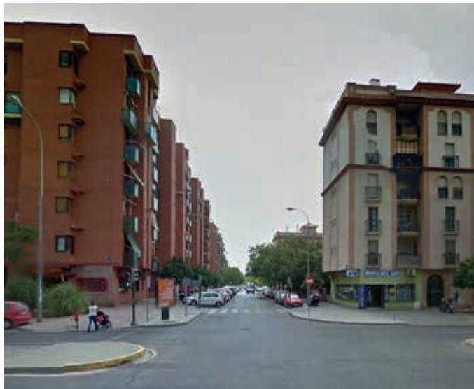
Vista panorámica de la avenida de Lagartijo.
