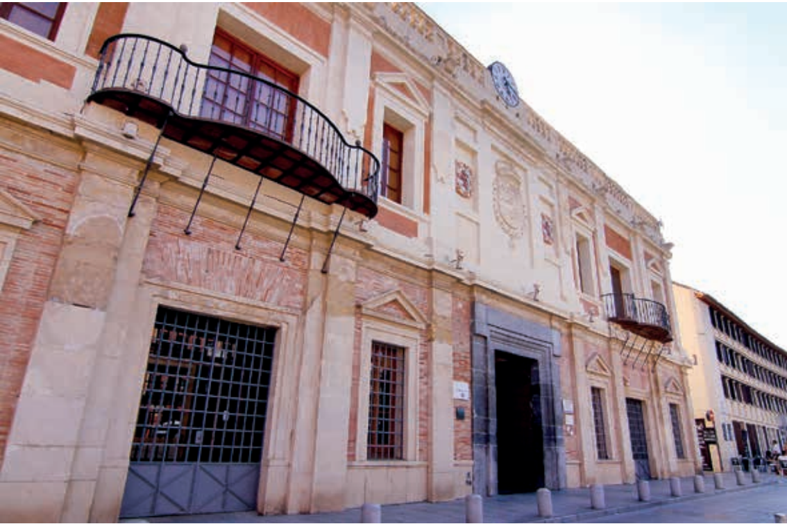
Fachada principal del mercado de La Corredera.
