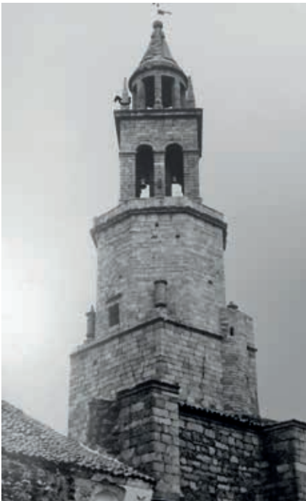
Vista parcial de la torre de Pedroche con el detalle de la flecha sobre el mojinete por donde los niños pasaban a riesgo de caer al vacío.
