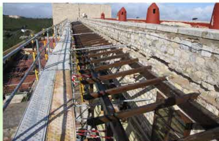
REPARACIÓN DE BALCONADAS DEL PARADOR DE TURISMO DE JAÉN
